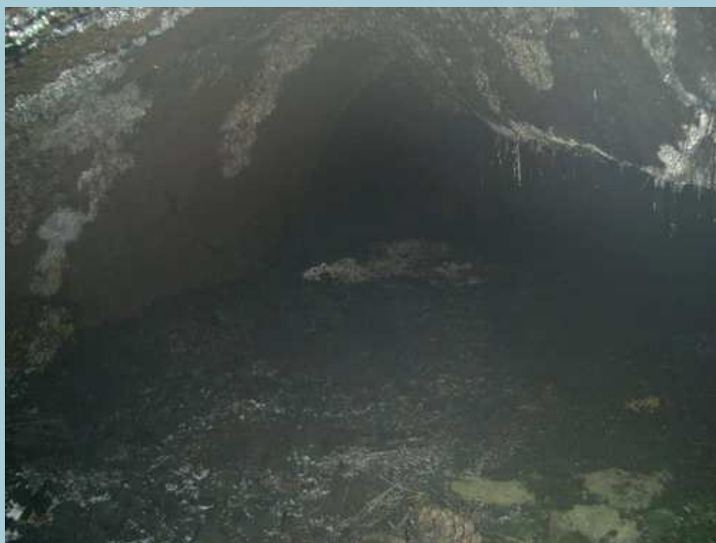
Foto 5 – Particolare interno della “Schiattatura”, dalle pareti del cunicolo si possono notare le spore presenti per via dell'elevato tasso di umidità e la differenza di temperatura con l'esterno.
