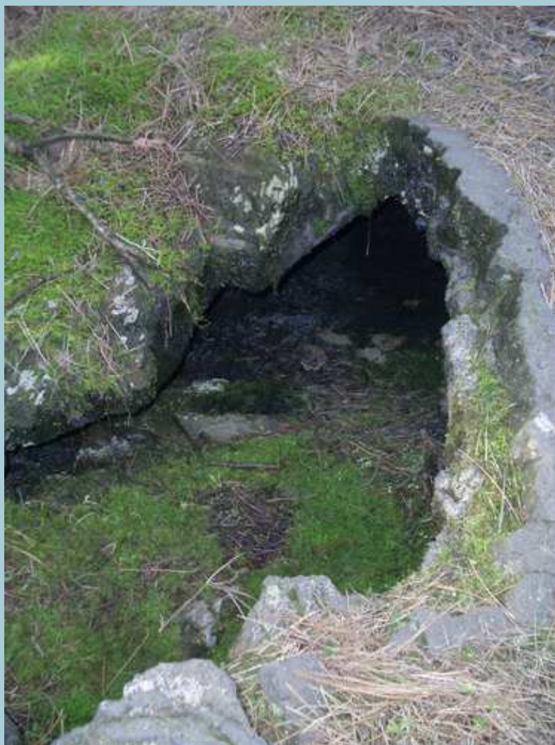
Foto 3 - Particolare esterno del cunicolo
