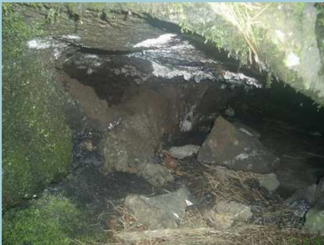
Foto 7 – Particolare di un altro cunicolo adiacente alla “Schiattatura” avente le stesse caratteristiche.
