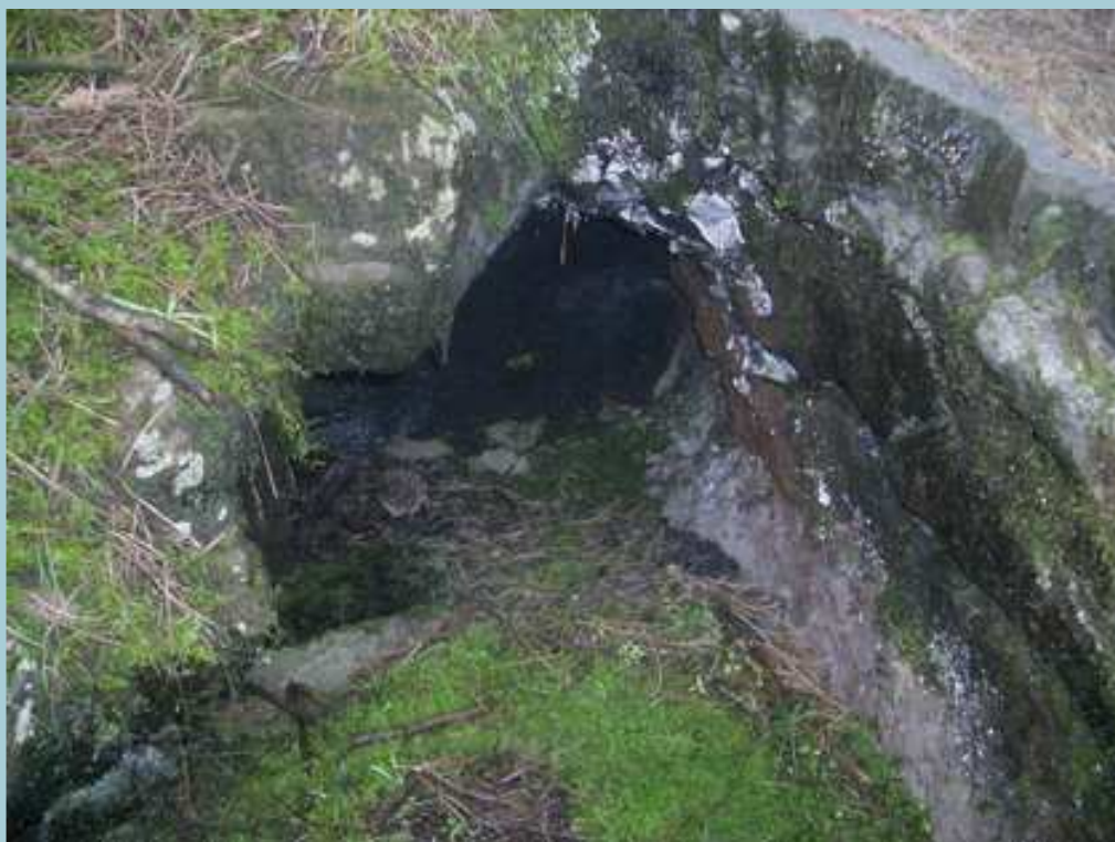
Foto 4 – Particolare dell'ingresso del cunicolo.
